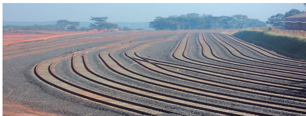
Figura 03 – O aumento do acesso ferroviário, Tutóia-SP.
